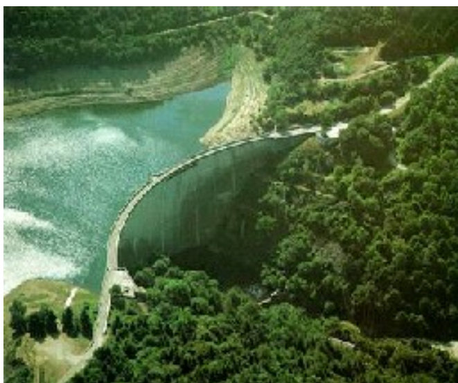
Barrage des Cammazes sur le Sor (cliché site ISL)
