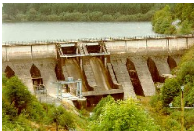
Barrage de la Raviège sur l'Agout (cliché EDF)
