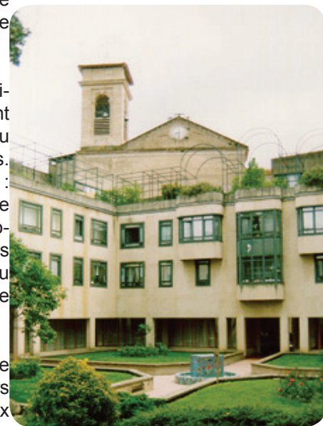
Résidence La Platé dans le centre ancien de Castres
