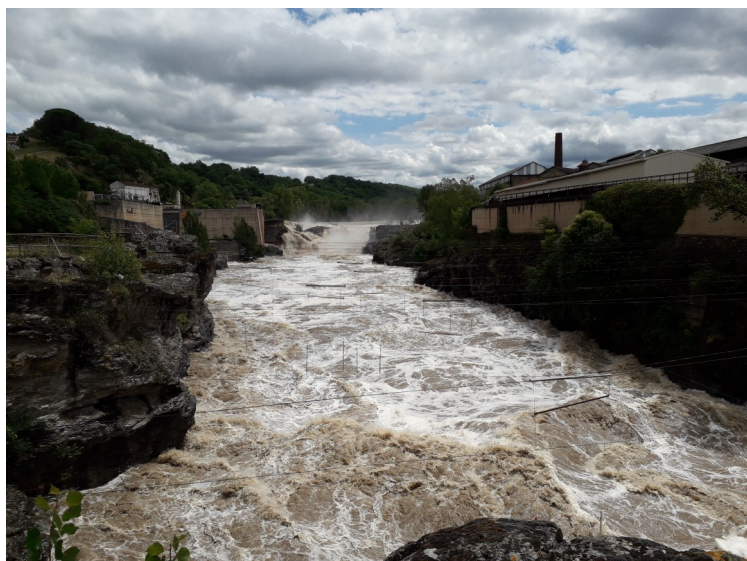
La rivière Tarn à Arthès – Crue du 13/06/2020
